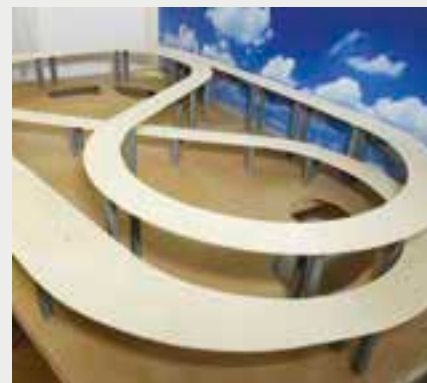
3. Die Gleistrasse ist fertig
